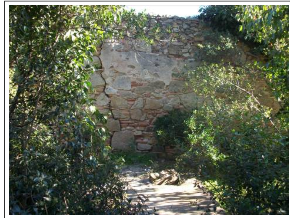
Foto 6: AP 2 Mur de tanca de la finca PA Can Mestres.
