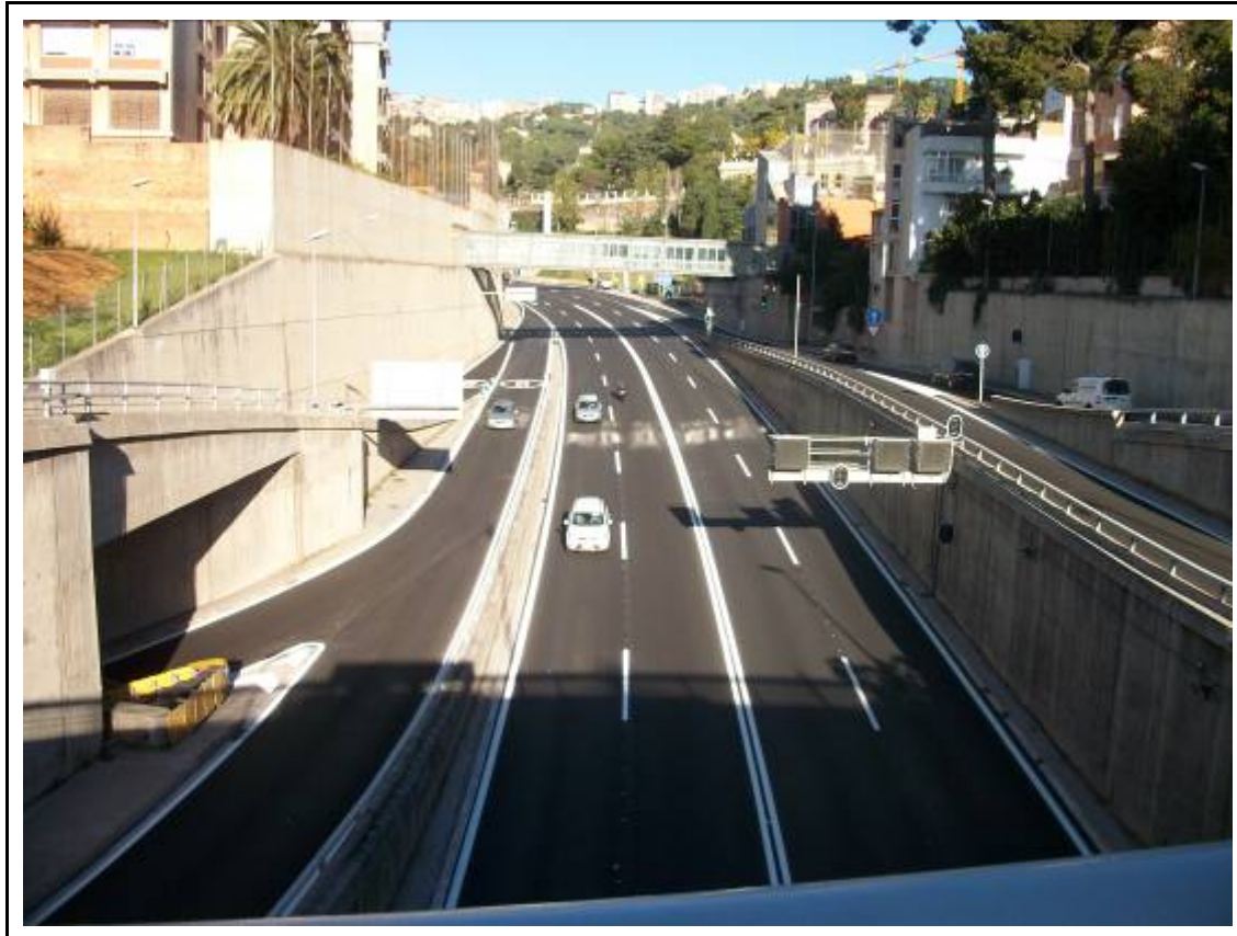
Foto 1: AP 1 Inici del Túnel de Vallvidrera des de la Ronda de Dalt.
