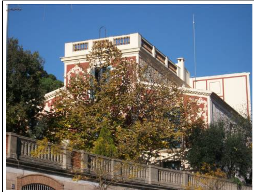
Foto 4: AP 1, PA Can Mestres des de l'Avinguda de Vallvidrera
