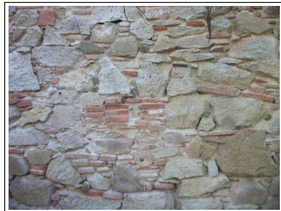
Foto 7: AP 2 Detall de l'obra de paredat del mur de Can Mestres.
